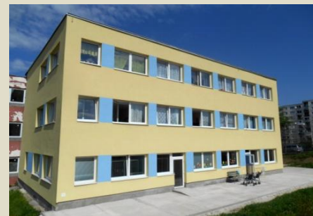
budova centra po rekonštrukcii
